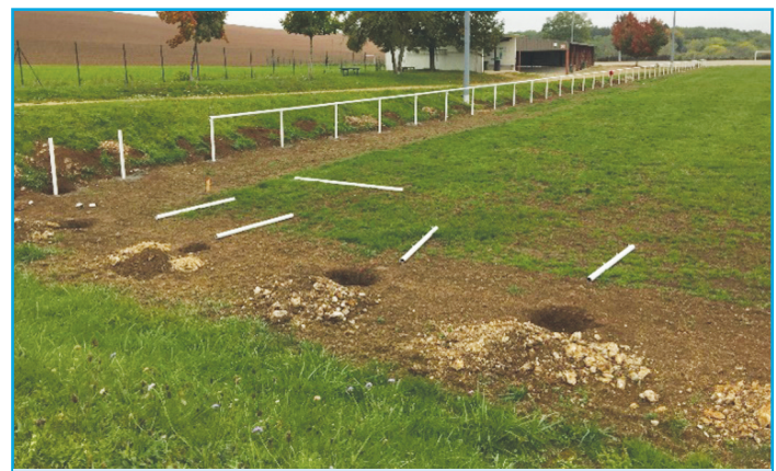
La pose des mains courantes
