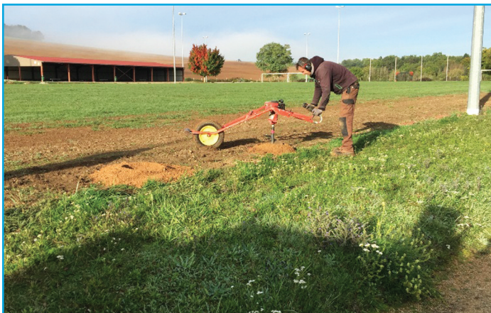
162 trous ont été forés pour la pose de la main courante
