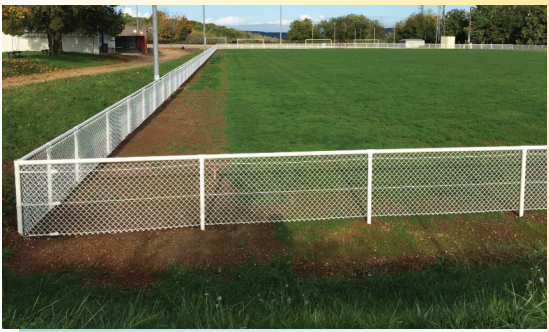
Travaux de mises aux normes au stade P. 7
