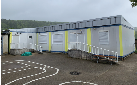
Des travaux à l'école maternelle
