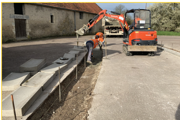
Changement des caniveaux sur le parking de la Brenne devant le bar "le Rad'O"
