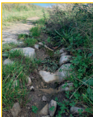
Photo de la zone 1 - pavage bien visible mais usé
