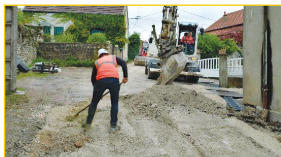
Préparation de la plateforme
