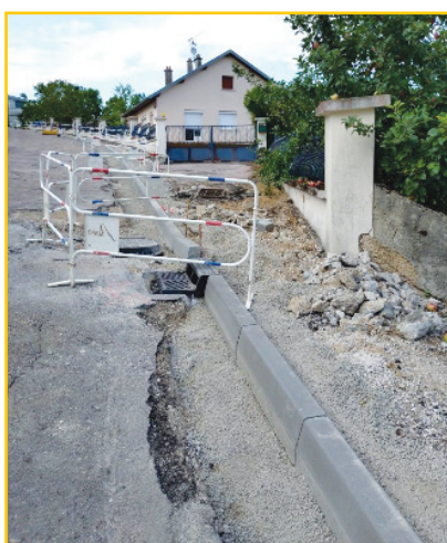
Pose de bordures et réfection du trottoir
