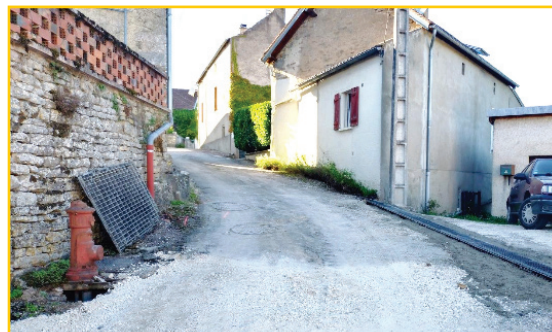
Pose de caniveaux
