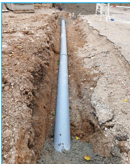
La remise en état du réseau
