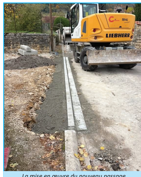
La mise en œuvre du nouveau passage pour accéder à la propriété.
