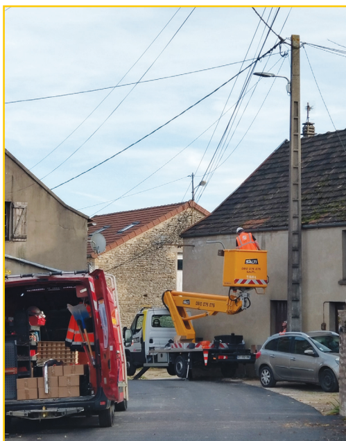
Les travaux ont été réalisés par l'entreprise Demongeot
