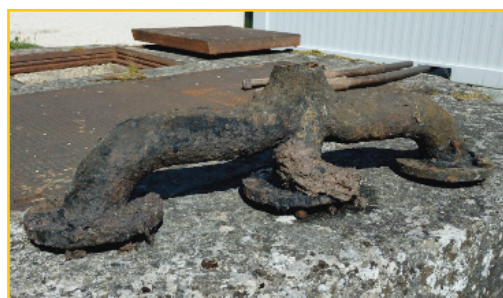
La pièce défectueuse
