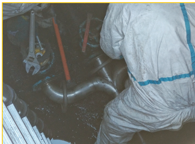
Mise en place de la nouvelle pièce
